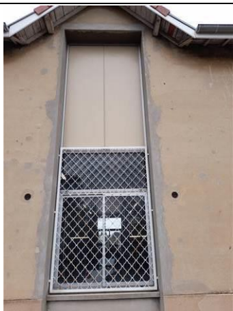
Photo n° PhA005 Localisation : R+1 - 371-N1-P-001 Description : Impostes de fenêtres - Plaques amiante ciment glasal
