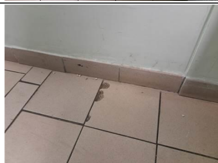
Photo n° PhA016 Localisation : RDC - 371-N0-P-008 Description : Colle de plinthes 10x20 beige
