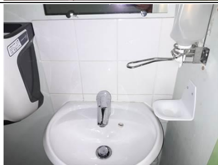
Photo n° PhA019 Localisation : RDC - 371-N0-P-010 Description : Colle de faïence 15x15 blanche
