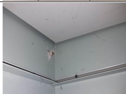
Photo n° PhA017 Localisation : RDC - 371-N0-P-010 Description : Cloisons - Placoplatre + bande à joint + peinture
