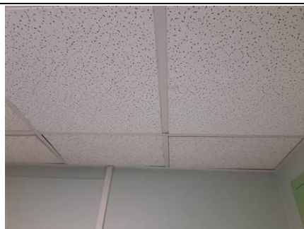
Photo n° PhA018 Localisation : RDC - 371-N0-P-008 Description : Dalle de faux plafond 60x60
